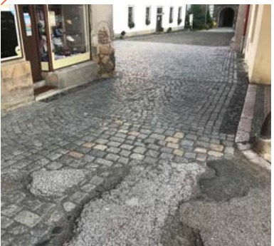
ASFALT POLOŽENÝ NA ŽULOVÉ KOSTKY
