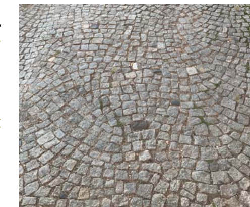
ŽULOVÁ KOSTKA NA ŠIROKOU SPÁRU, NEPRAVIDELNÁ, KONEC 20. STOL.
