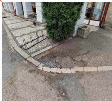
ASFALT POLOŽENÝ NA ČEDIČOVÉ DLAŽBĚ
