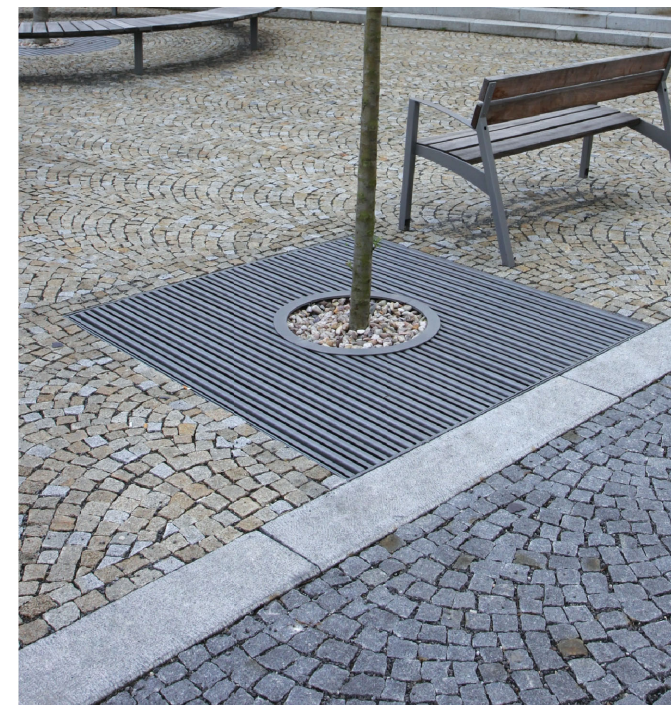
OCELOVÁ MŘÍŽ KE STROMŮM - V PŘÍPADĚ NUTNOSTI
