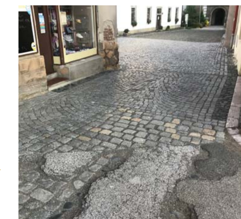
ASFALT POLOŽENÝ NA ŽULOVÉ KOSTKY
