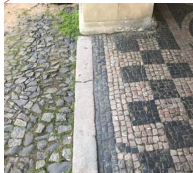
ODSAZENÍ KOMUNIKACE, ČEDIČOVÁ DLAŽBA NA DIVOKO
