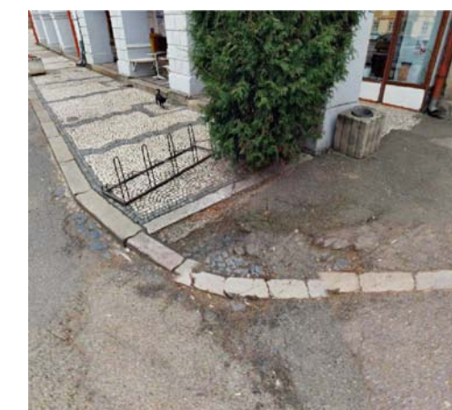
ASFALT POLOŽENÝ NA ČEDIČOVÉ DLAŽBĚ
